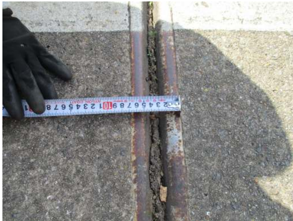
신축이음 유간거리 측정
