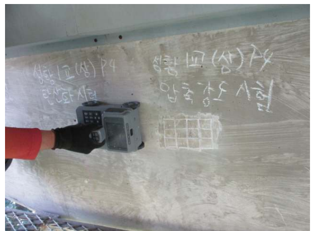
철근 피복두께 측정
