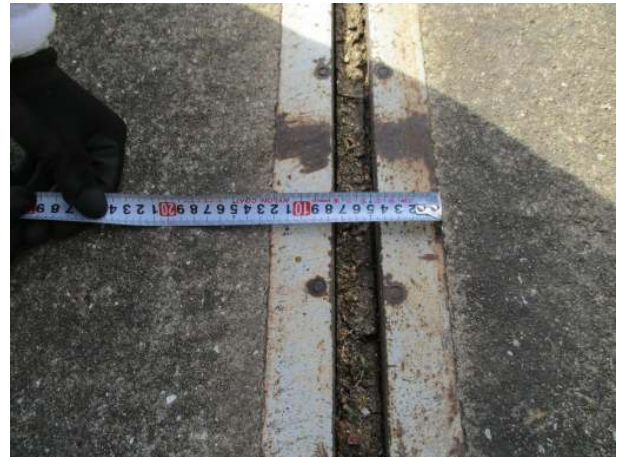
신축이음 유간거리 측정
